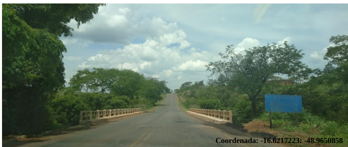
Figura 31. Terceira ponte, sentido Senador Canedo - Bonfinópolis
