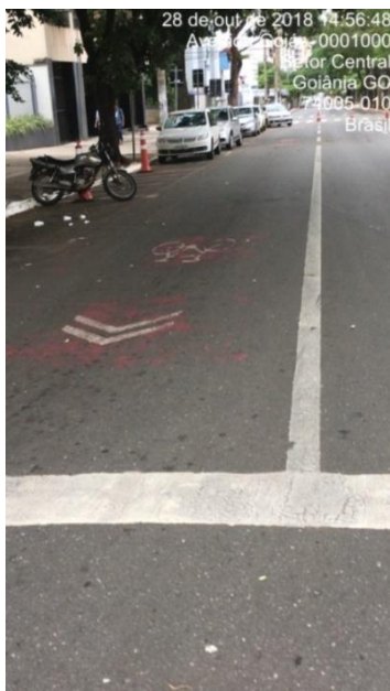
Figura 7 - Sinalização horizontal (Avenida Goiás)
