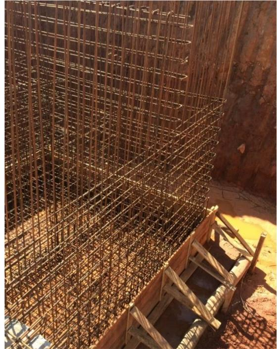
Figura 4 – Forma e Armação para execução do reator.
