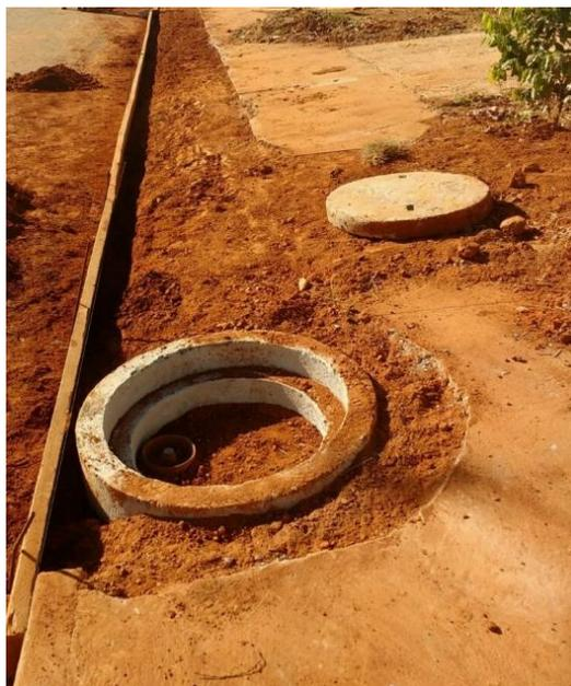
Figura 2 – Corte de calçada de concreto
