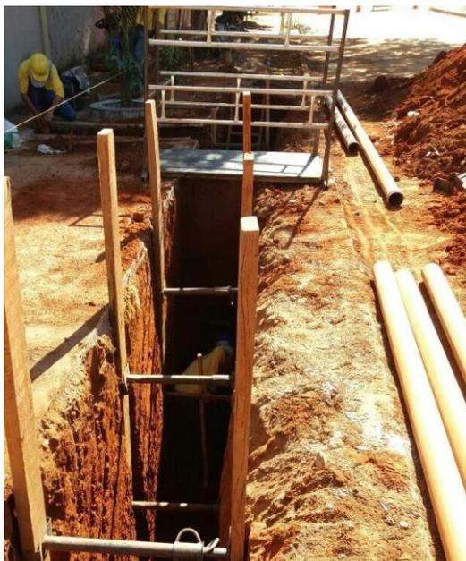
Figura 1 – Escavação para execução da rede.
