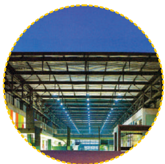
Figura 55. Estrutura metálica de aço
