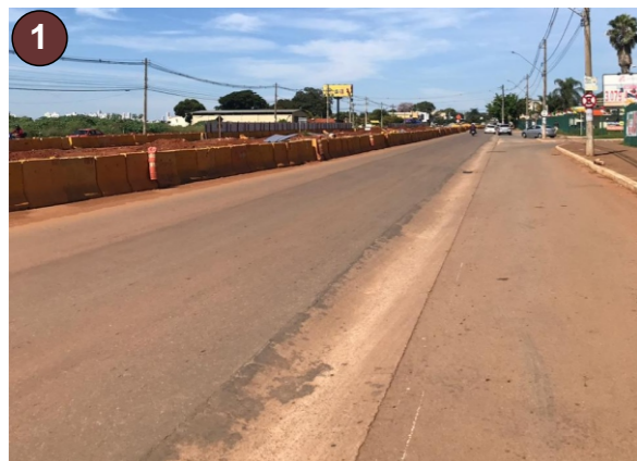
Imagem 17: Malha asfáltica. Fonte: Marcos Vinícius, 2019.
