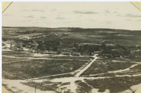
Figura 54: Setor Norte Ferroviário, visto do alto do prédio da Estação Ferroviário
