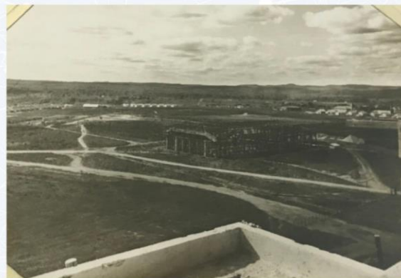
Figura 56: Setor Norte Ferroviário, visto do alto do prédio da Estação Ferroviário
