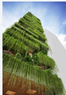
Figura 113: Vegetação nas lajes e sacadas
