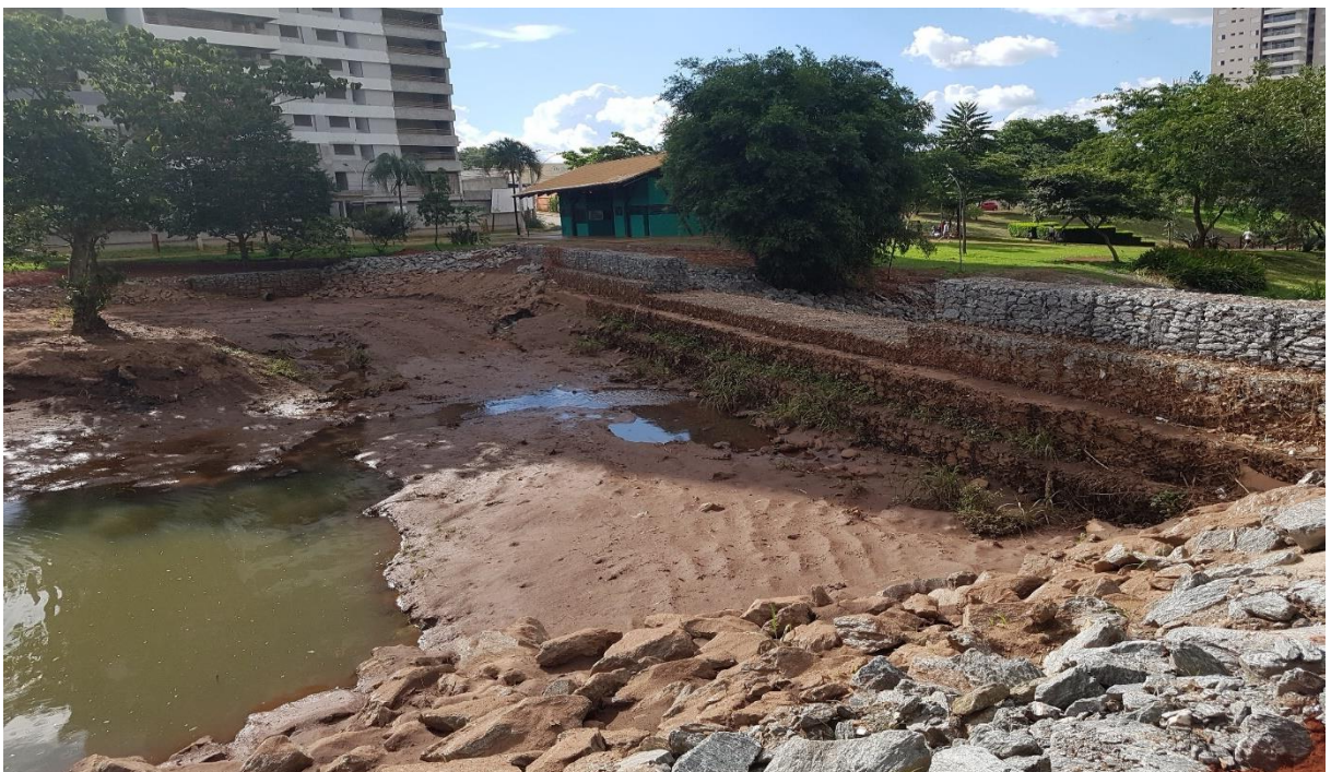
Figura 5. Barramento de contenção com assoreamento aparente.
