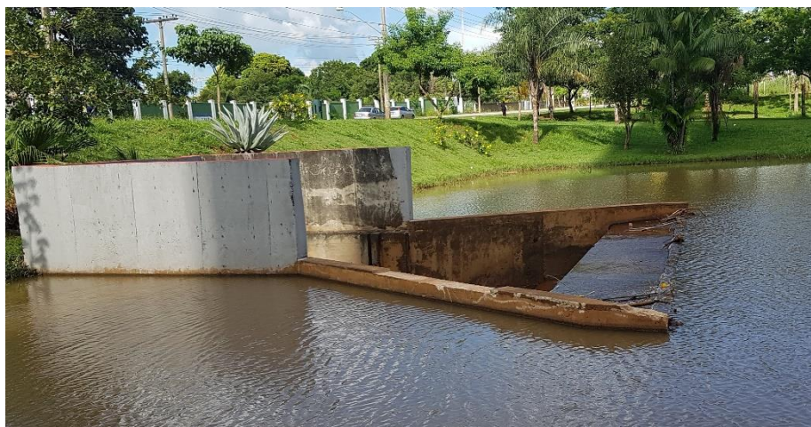
Figura 9. Caixa de nível tipo monge, parque cascavel.
