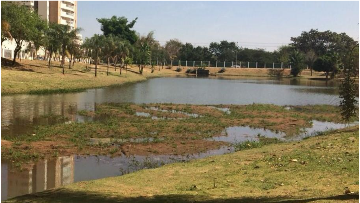
Figura 2. Reservatório com assoreamento antes da revitalização.
