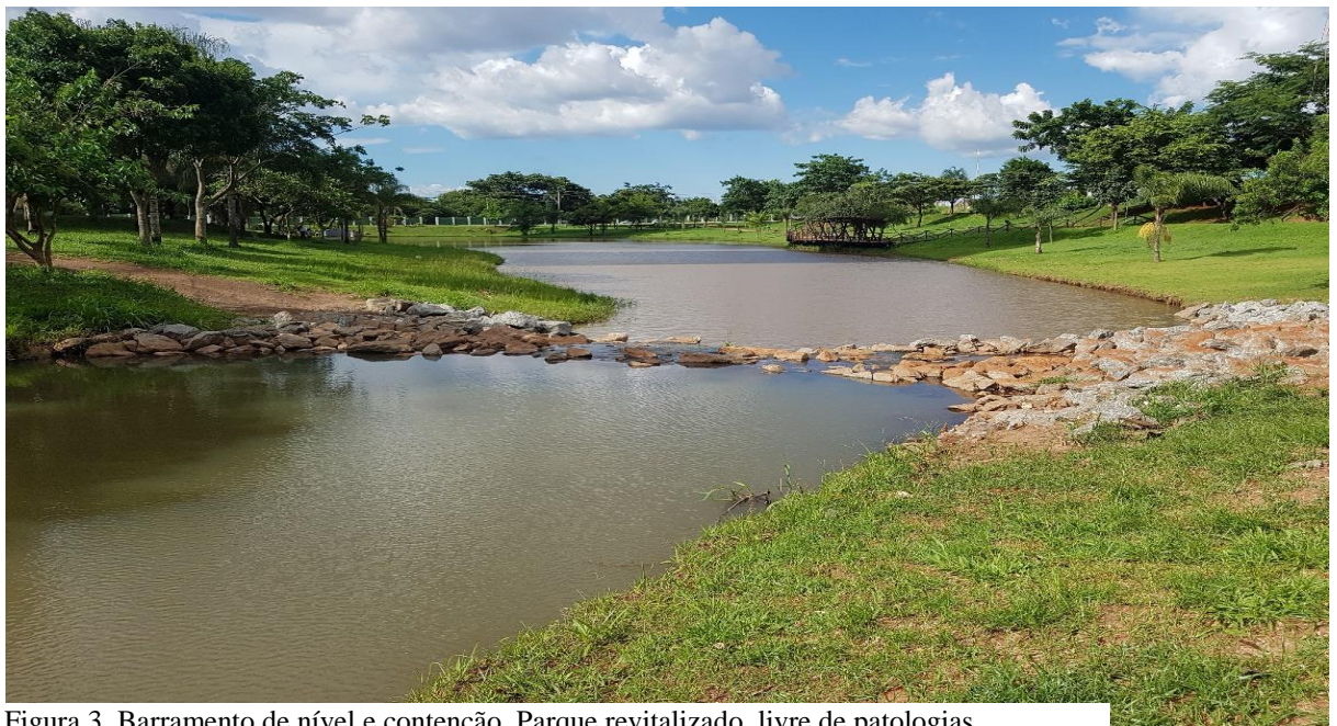
Figura 3. Barramento de nível e contenção. Parque revitalizado, livre de patologias.
