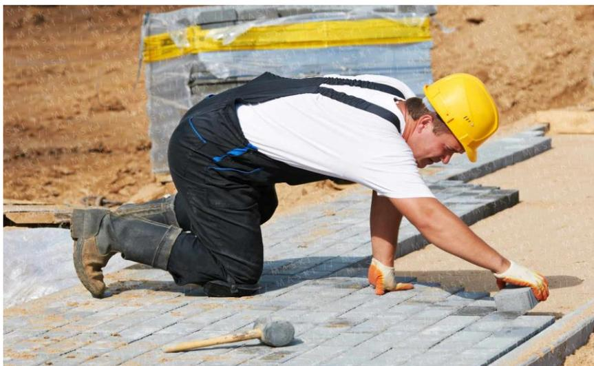
Figura 11. Processo de Assentamento do Paver.
