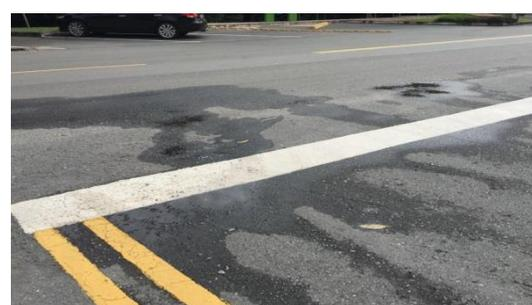
Figura 8. A,B,C e D – Acúmulo de água superficial no revestimento.
