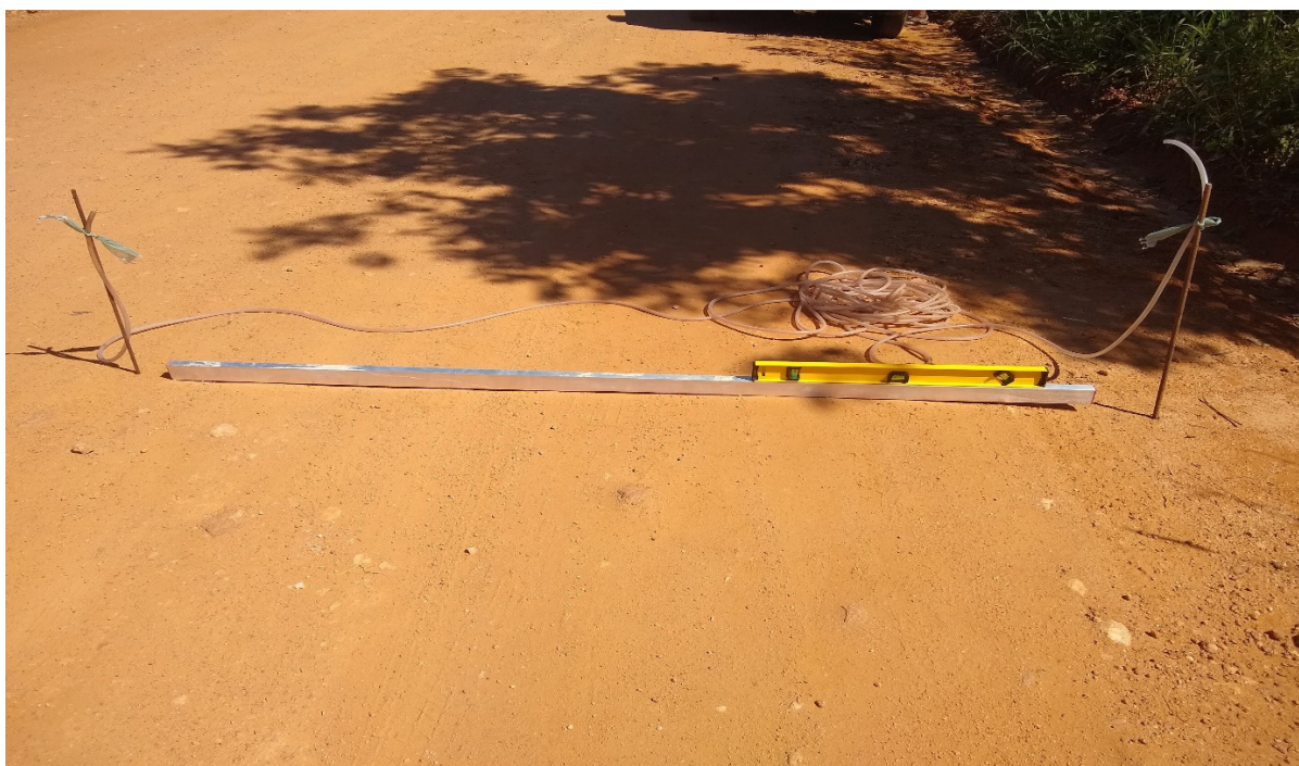
Figura 2. Medindo a inclinação da seção transversal.
