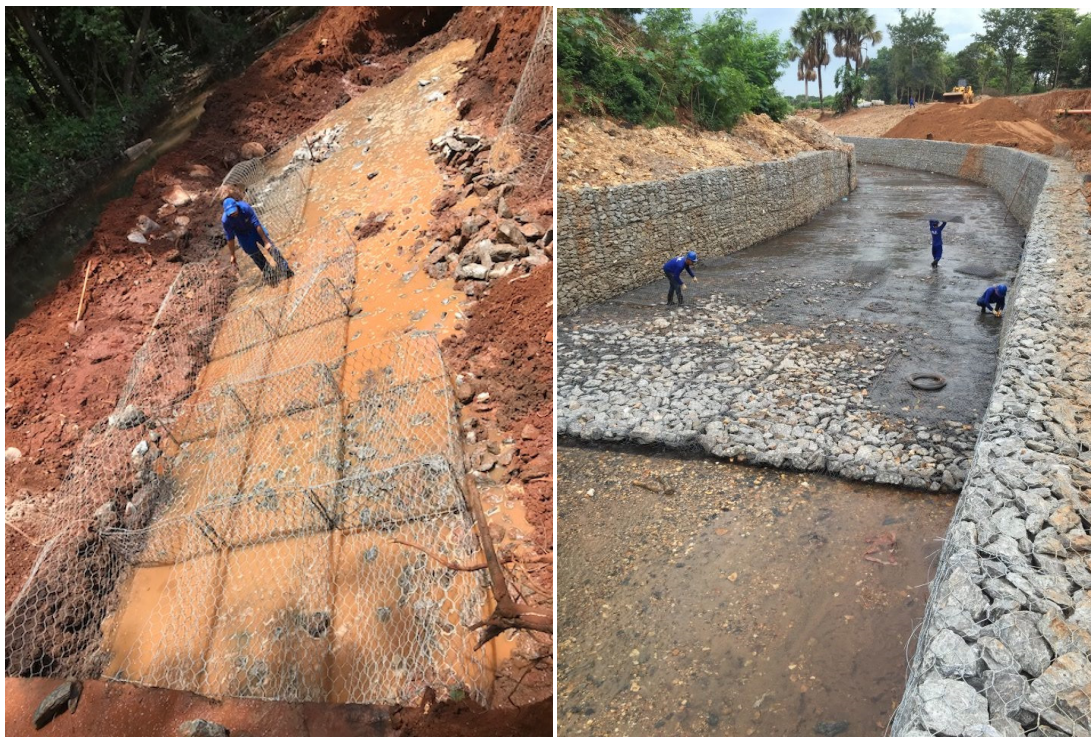
Figura 05. Instalando tampas nos Colchões. Figura 06. Costura dos Colchões Reno.
