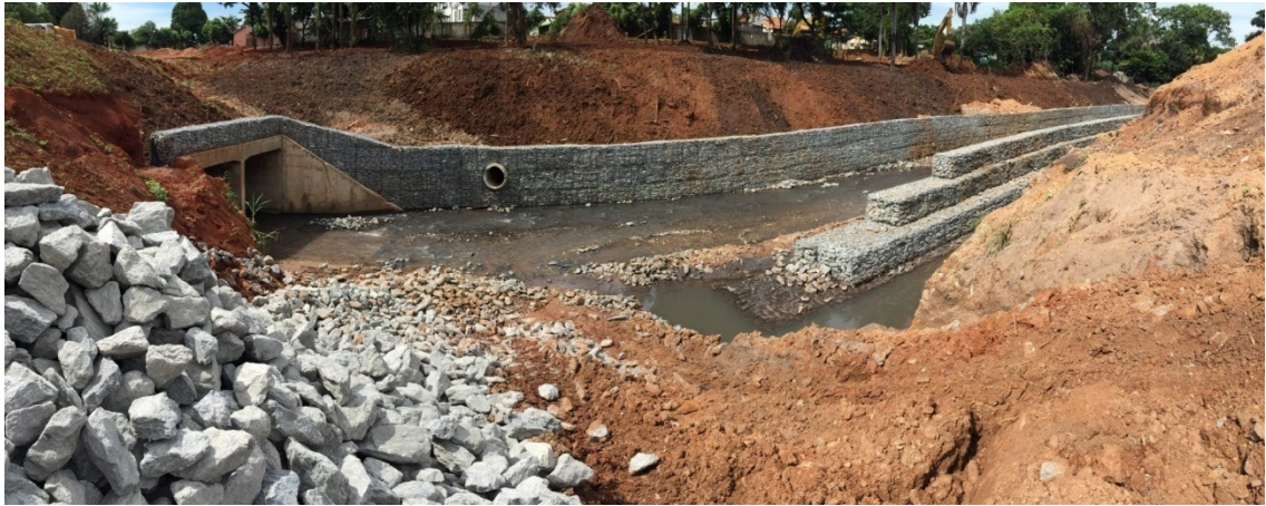
Figura 18: Imagem ilustrando as três camadas do gabião.
