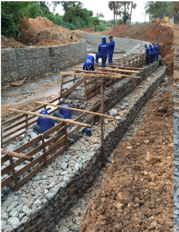
Figura 10. Instalação do gabarito na parte frontal. Figura 11. Uso do gabarito.
