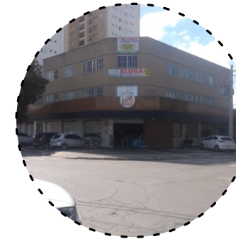
Figura 41: Edificação Mista. Fonte: Andressa Fortuna, 2019.
