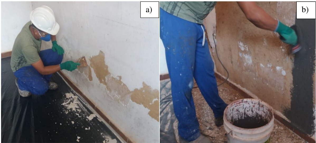
Figura 9. a) preparação do substrato; b) início da aplicação do impermeabilizante.
