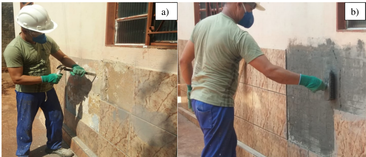
Figura 12. a) remoção de revestimento; b) aplicação do impermeabilizante.
