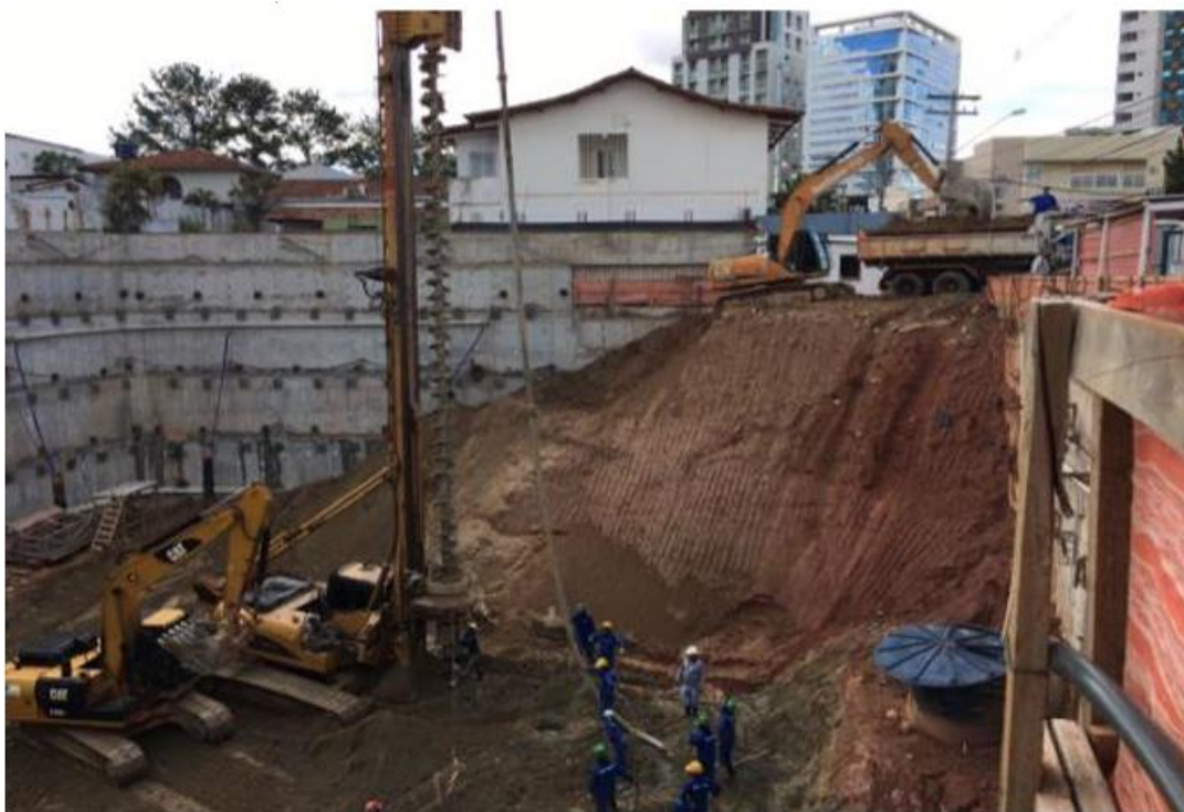
Figura 6: Etapa da primeira escavação Fonte: Grupo CF + (2017)
