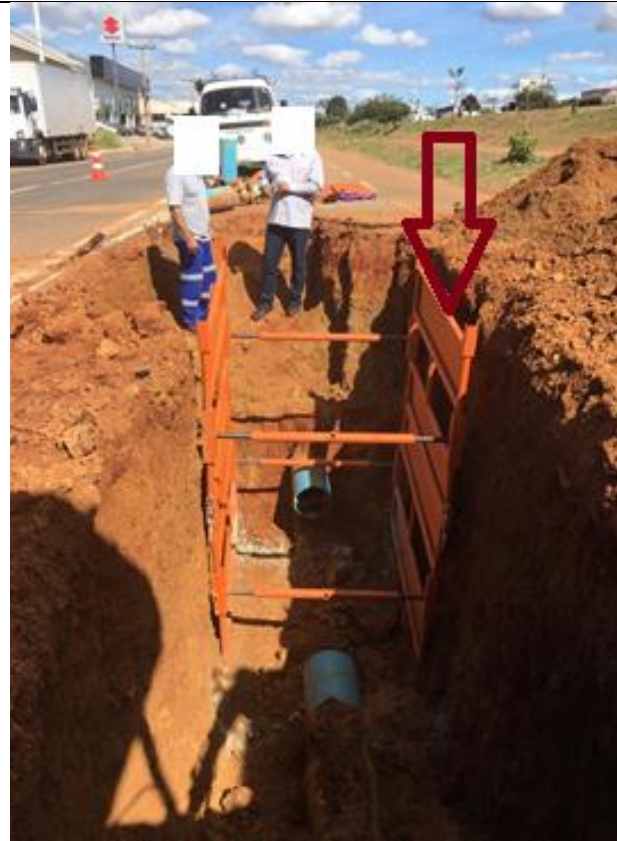
Figura 13. Utilização de estrutura metálica nos serviços que envolvam aberturas de valas
