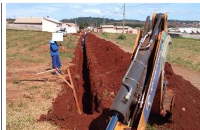
Figura 3. Instalação de nova rede distribuição de água
