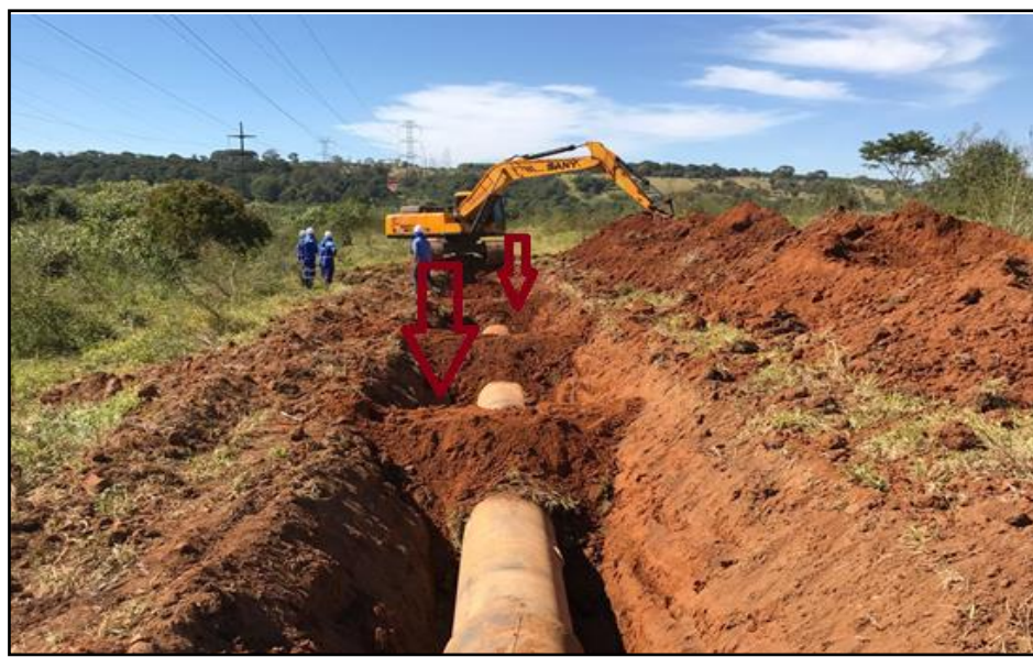
Figura 92. Contenção mista com talude inclinado e com uso da dama
