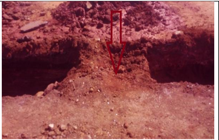
Figura 8 .A contenção do talude com uso da Dama
