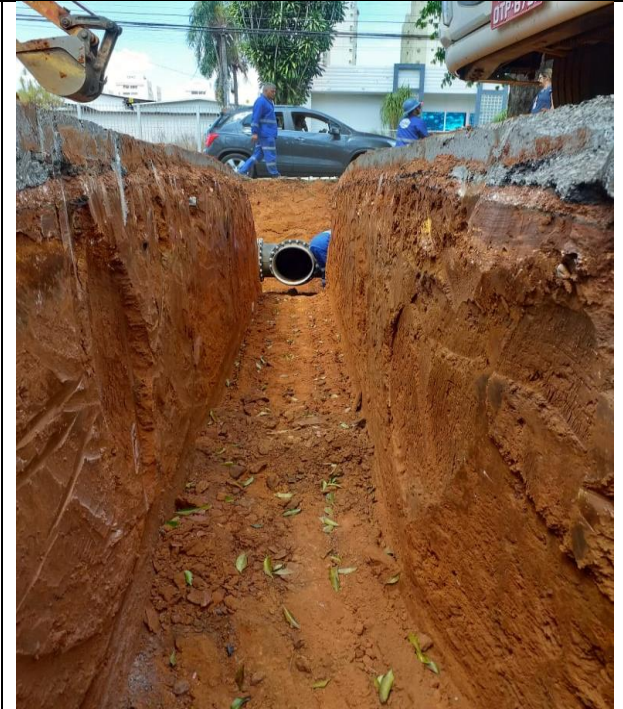
Figura 12: TRECHO. JOÃO LEITE MANUTENÇÃO DE ÁGUA
