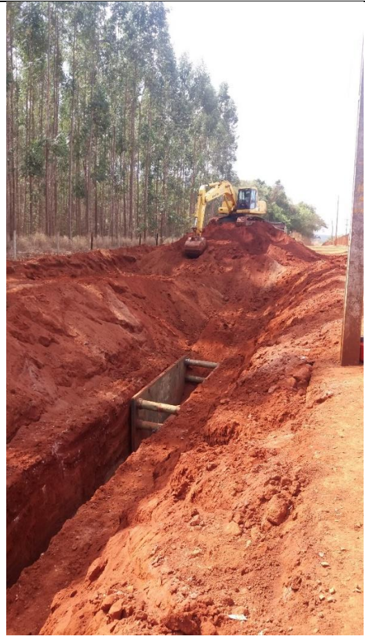
Figura 14. Estrutura metálica do tipo blindado
