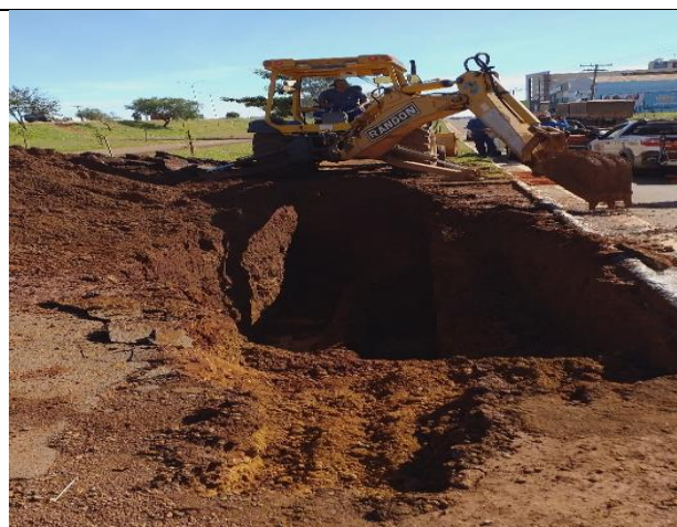
Figura 2. Processo de Escavações Mecanizada
