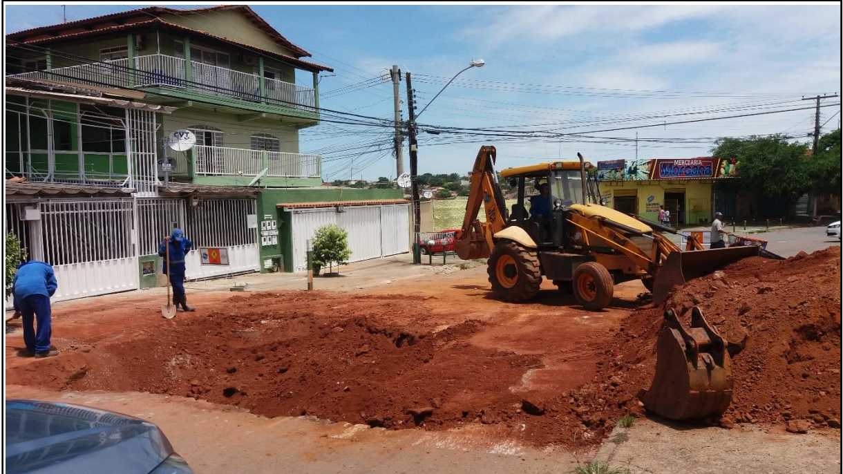
Figura 10. Recuperação da manta asfáltica
