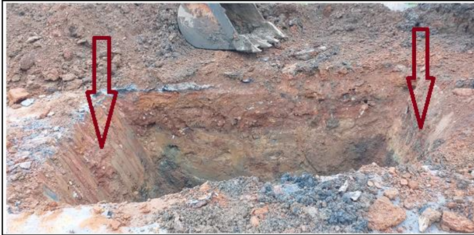
Figura 5 . Taludes inclinado - em mautenção de esgoto
