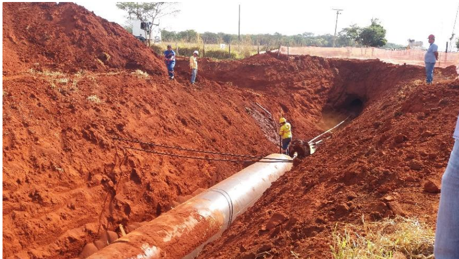
Figura 5. Trecho GO- 080 Escavações não destrutiva - trincheiras subterrâneas
