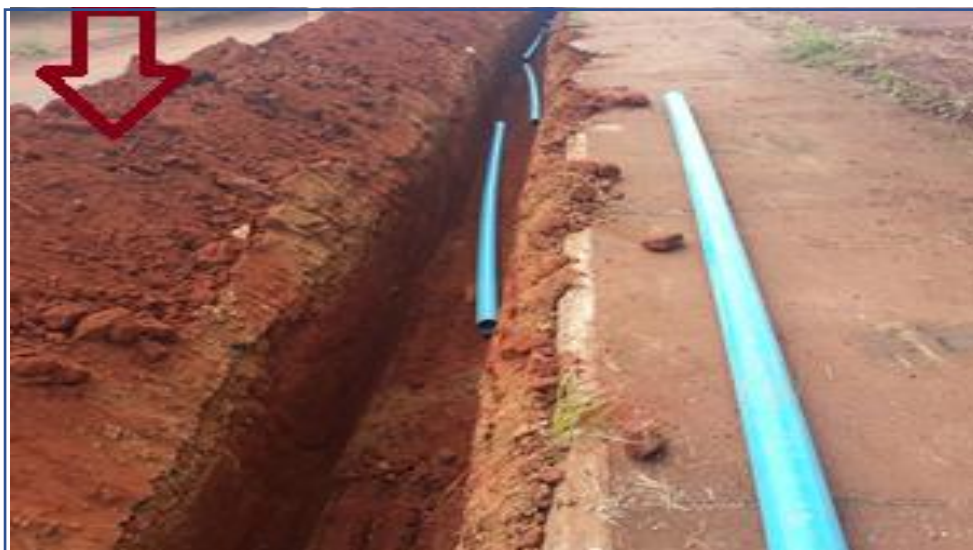
Figura 7. material escavado nas bordas do talude
