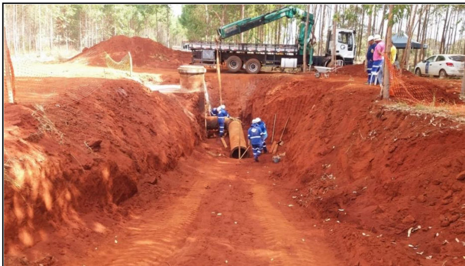
figura 6. Talude inclinado " Taludado"
