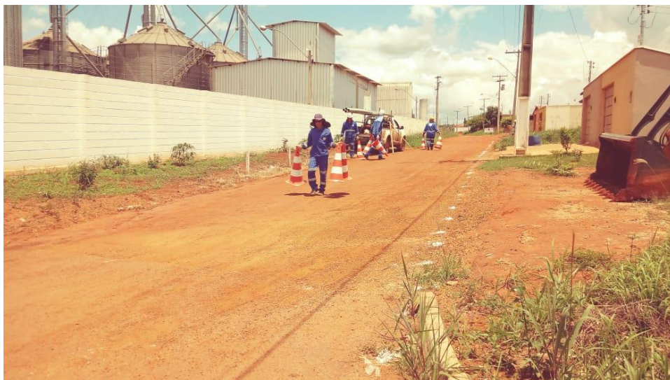
Figura 6. Sinalização das vias e locação da vala
