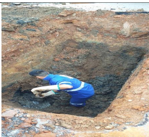
Figura 1. Processo de Escavações Manual
