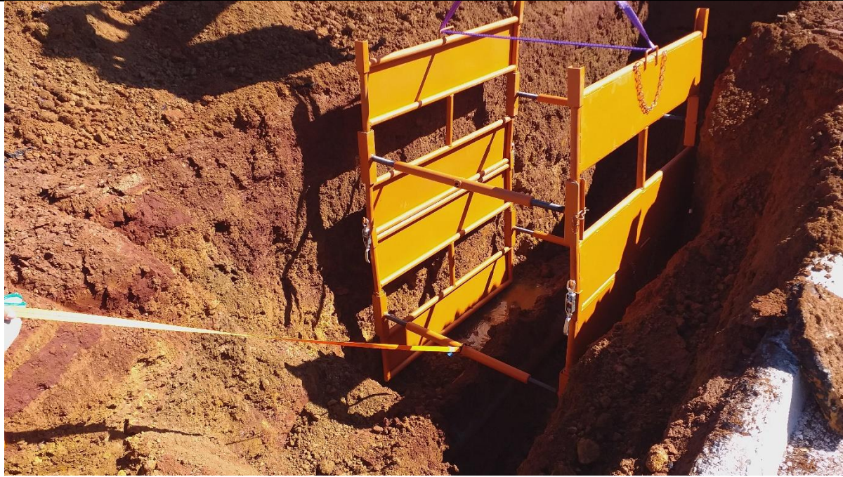
Figura 13: TRECHO. MANUTENÇÃO ÁGUA GOIÂNIA
