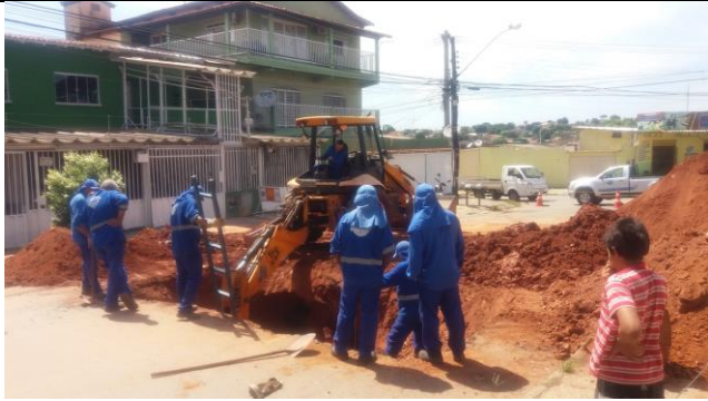
Figura 10: MANUTENÇÃO ESGOTO - PALMITO
