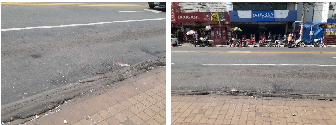
Figuras 4 (a e b) : Afundamento plástico da trilha de roda. Fonte: RABELO (2019).
