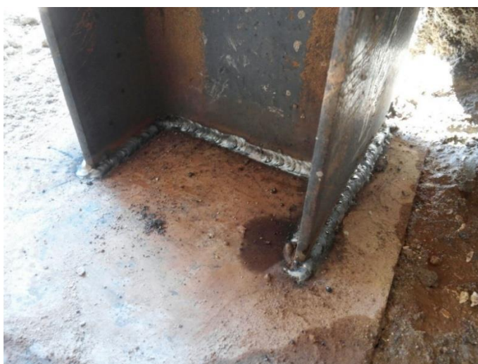
Figura 16: Pilar soldado no Coroamento (Chapa de Base).
