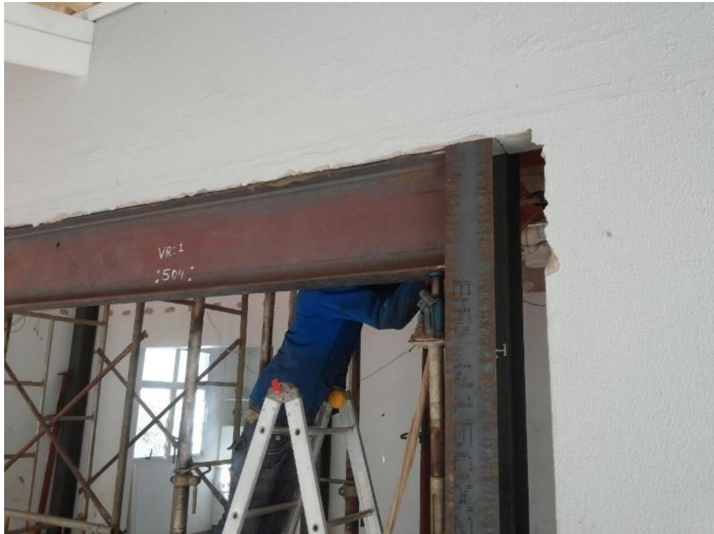
Figura 17: Colocação de Viga (macaqueamento). Fonte: Autores
