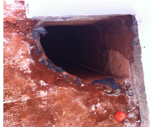
Figura 15: Fuste da Fundação. Fonte: Autores
