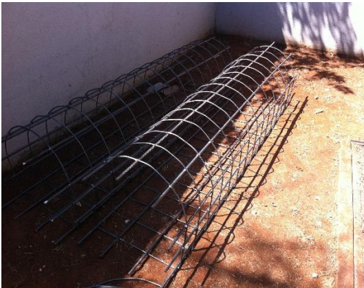
Figura 13: Armação da Fundação. Fonte: Autores
