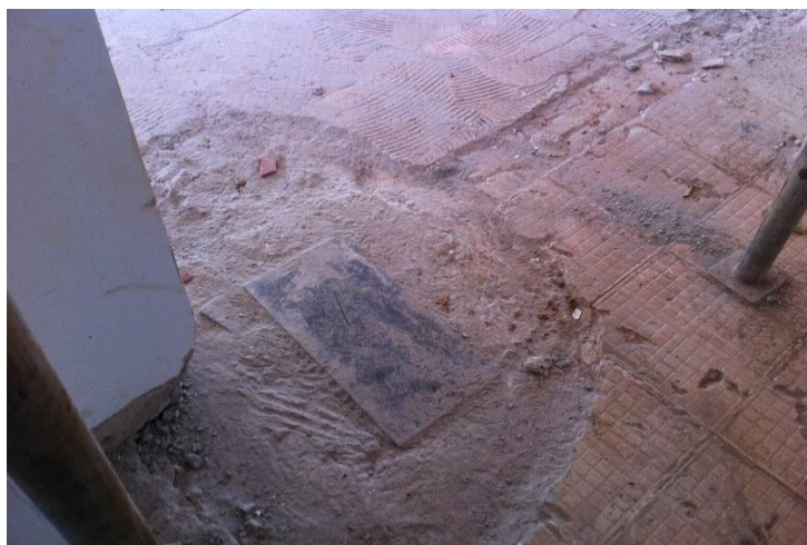
Figura 15: Coroamento da Fundação (Chapa de Base).
