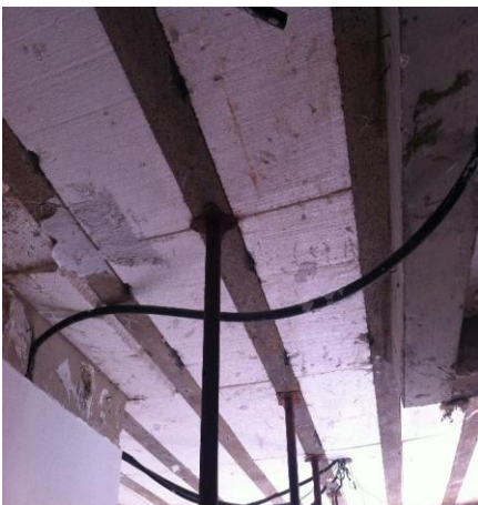
Figura 09: Escoramento do pav. Térreo.
