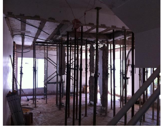
Figura 12: Alvenaria Removida. Fonte: Autores
