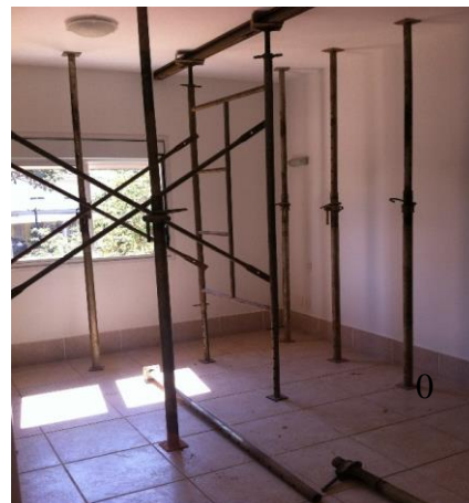
Figura 10: Escoramento do pav. Superior.
