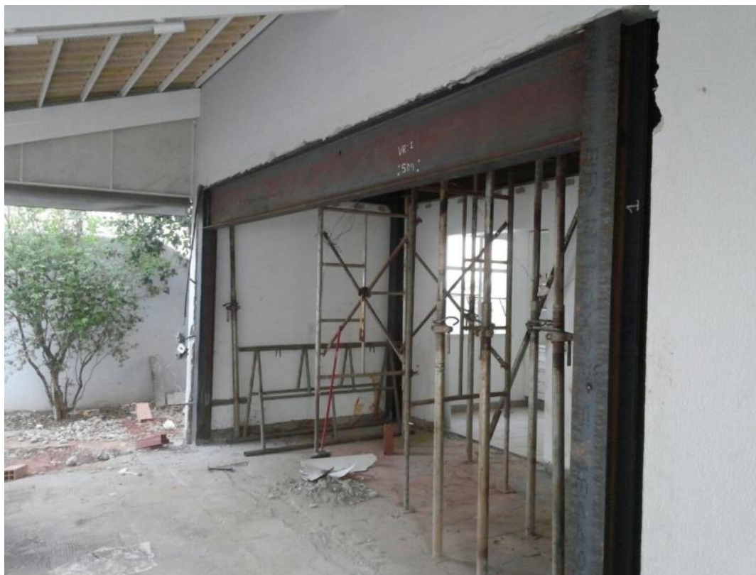
Figura 18: Pórtico Finalizado. Fonte: Autores
