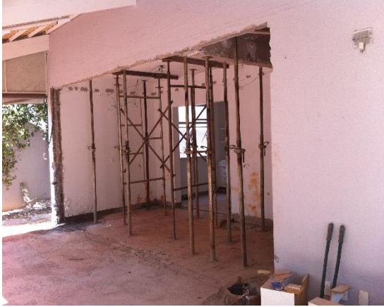
Figura 11: Remoção da Alvenaria. Fonte: Autores
