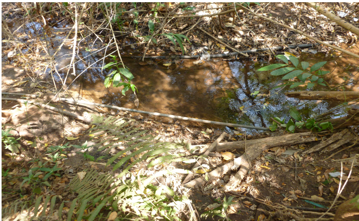
Figura 19. Mangueiras de captação da água do Córrego Fundo.
