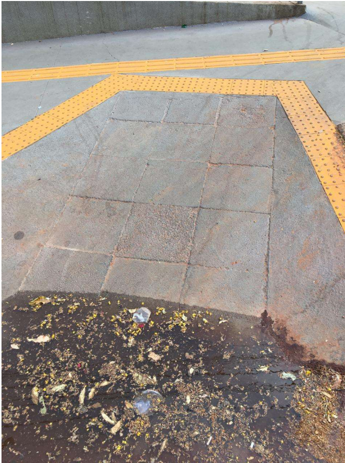
Figura 12. Rampa de acesso localizada na Avenida 10
