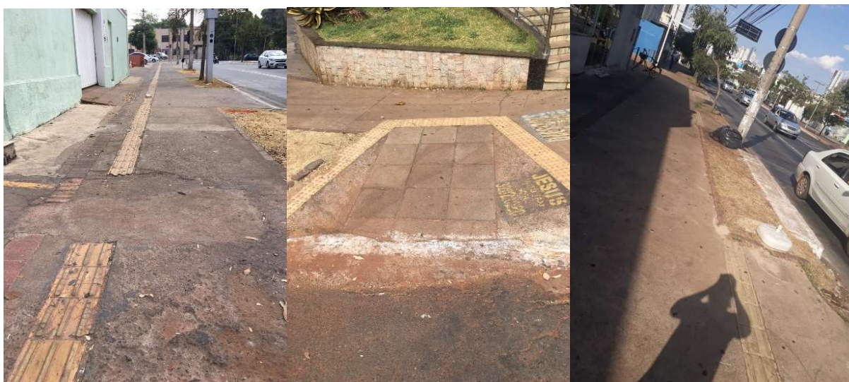
Figuras 9, 10 e 11. Calçamento da Avenida 10.
