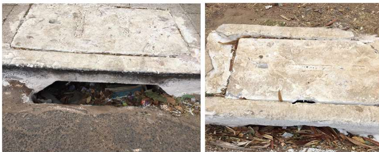
Figura 2. Dispositivos de Drenagens – Boca de Lobo – Avenida Independência
