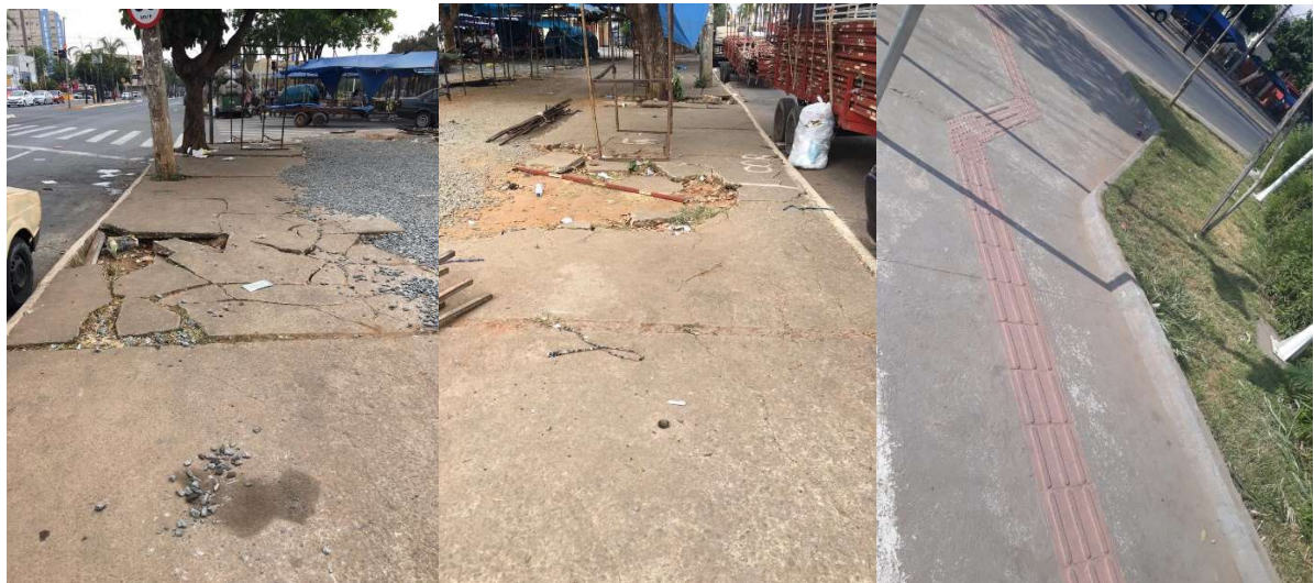
Figura 6, 7 e 8. Calçamento da Avenida Independência entre Rua 44 e Rua 74.
