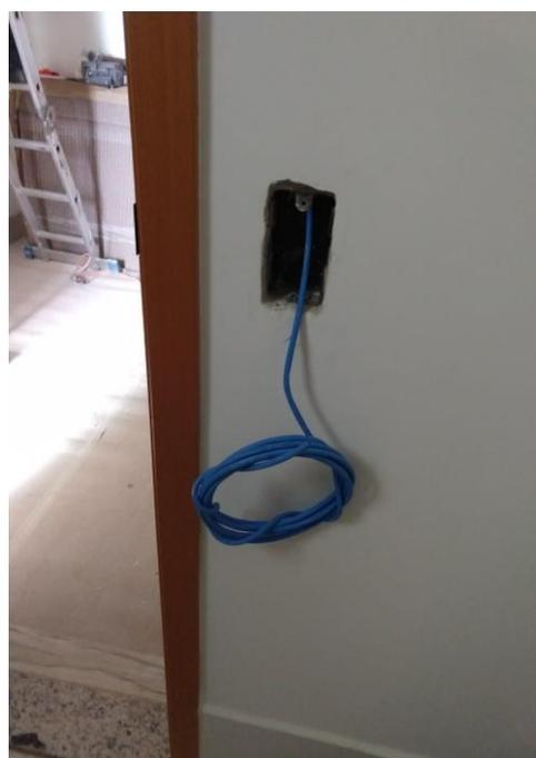
Figura 5. Reparo na alvenaria para instalação das caixas de passagem.
