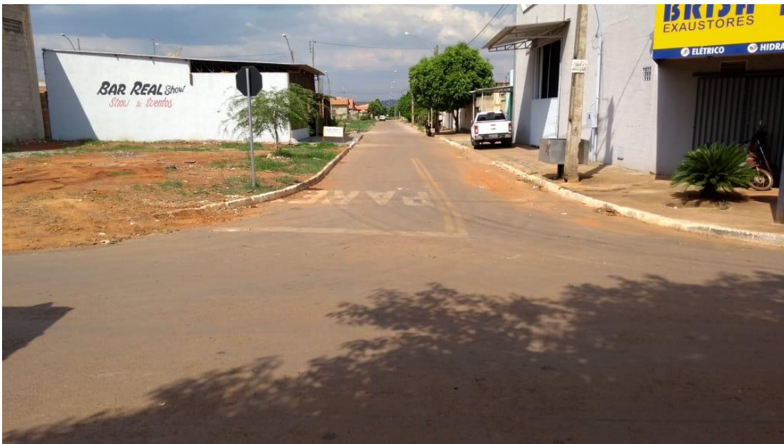
Figura 17. Lote baldio e asfalto irregular.
