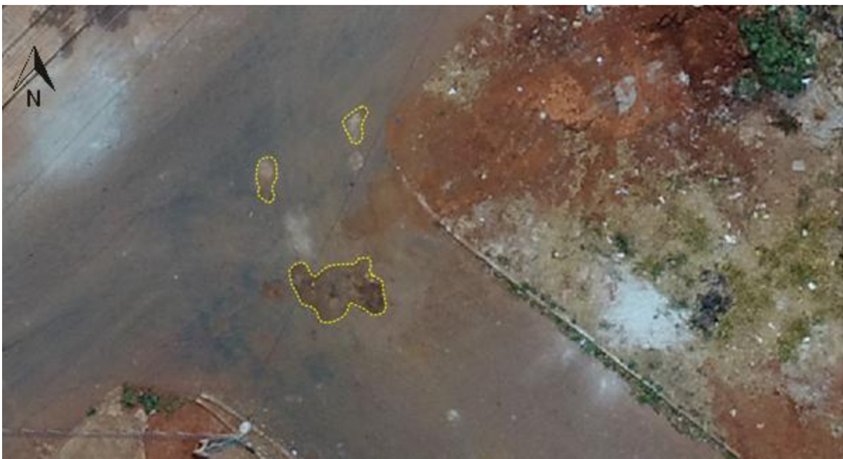
Figura 13. Via pavimentada com patologia vetorizada.
