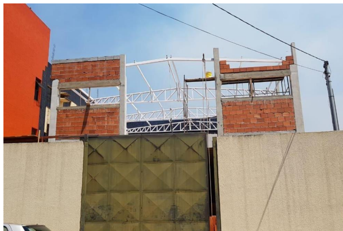
Figura 1. Estrutura galpão industrial localizado em Goiânia.
