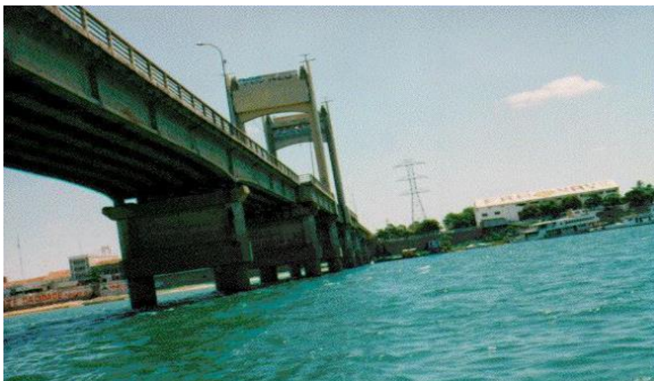
Figura 3. Ponte de Juazeiro Fonte: VERÍSSIMO (1998)
