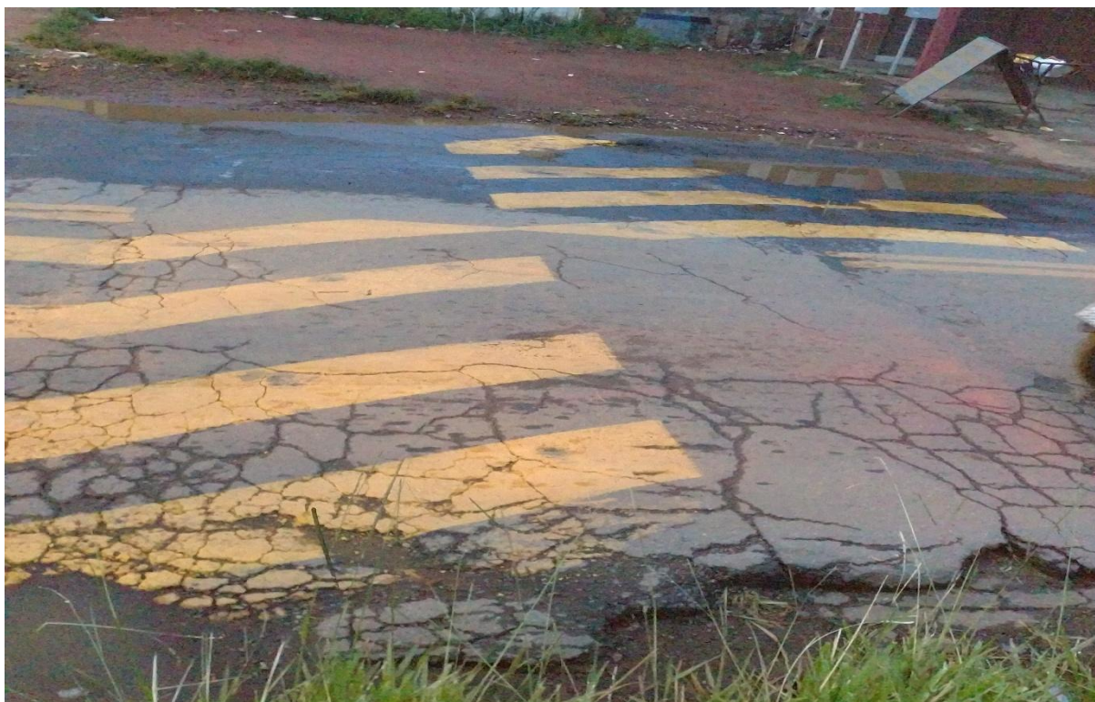
Figura 02: Falta de sinalização vertical para lombadas.
