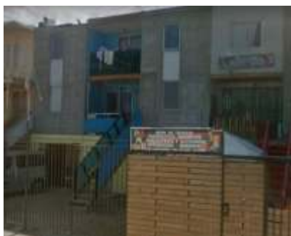
Figura 16: Quinta Monroy Utilização do comercio no térreo Fonte<: Archdaily > Acesso em Março de 2019
