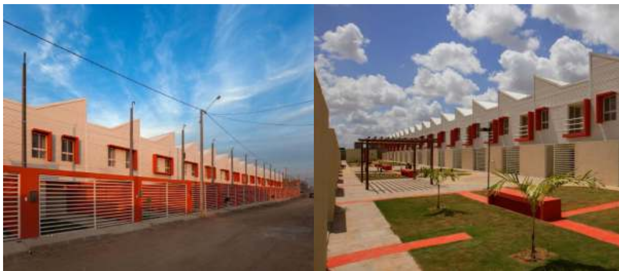
Figura 5: Residencial Clodoaldo Sampaio Vista do Conjunto Fonte<: Archdaily> Acesso em Março de 2019
