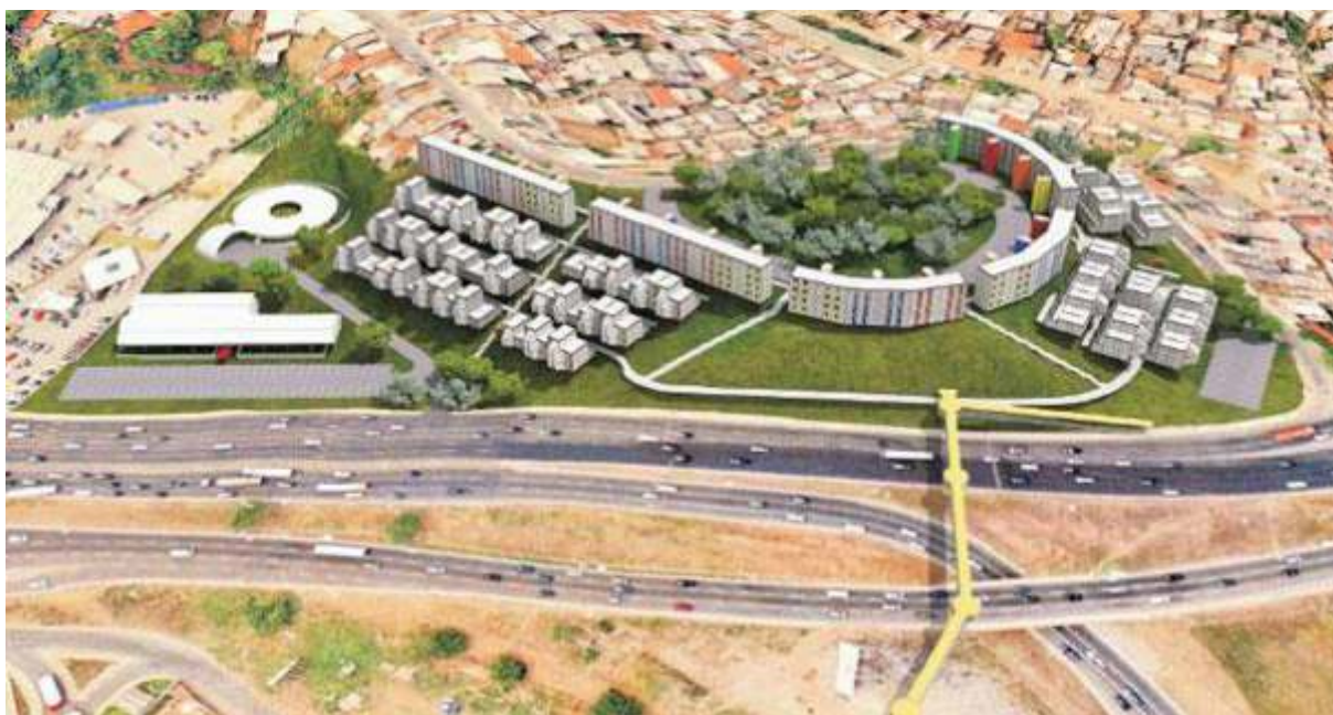
Figura 17: Comunidade de Pernambués Vista da Comunidade Fonte<: Archdaily > Acesso em Março de 2019
