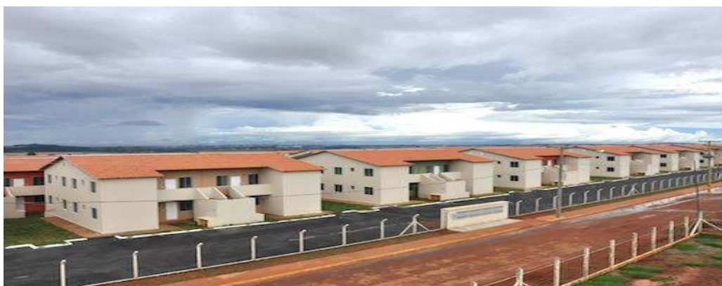
Figura 2: Conjunto Habitacional Jardim Cerrado 7 Fonte :< https://www.flickr.com/photos/iris20172020 > Acesso em Março de 20
