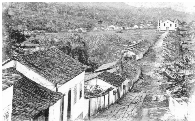
Figura 05: Ao fundo, a Igreja de Nossa Senhora do Rosário dos Pretos com duas torres – 1886 https://pirenopolis.tur.br
