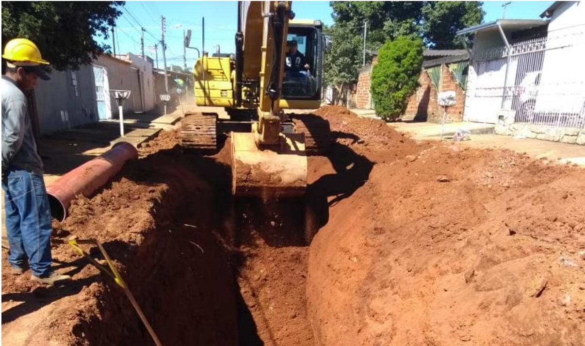
Figura 5. Serviço de escavação feito com escavadeira hidráulica.
