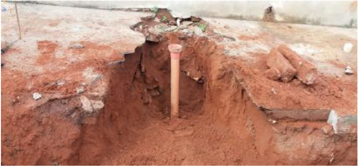
Figura 10. Execução de ramal domiciliar.
