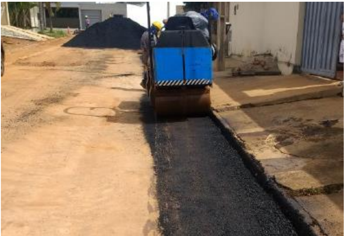
Figura 14. Reposição asfáltica tipo CBUQ.
