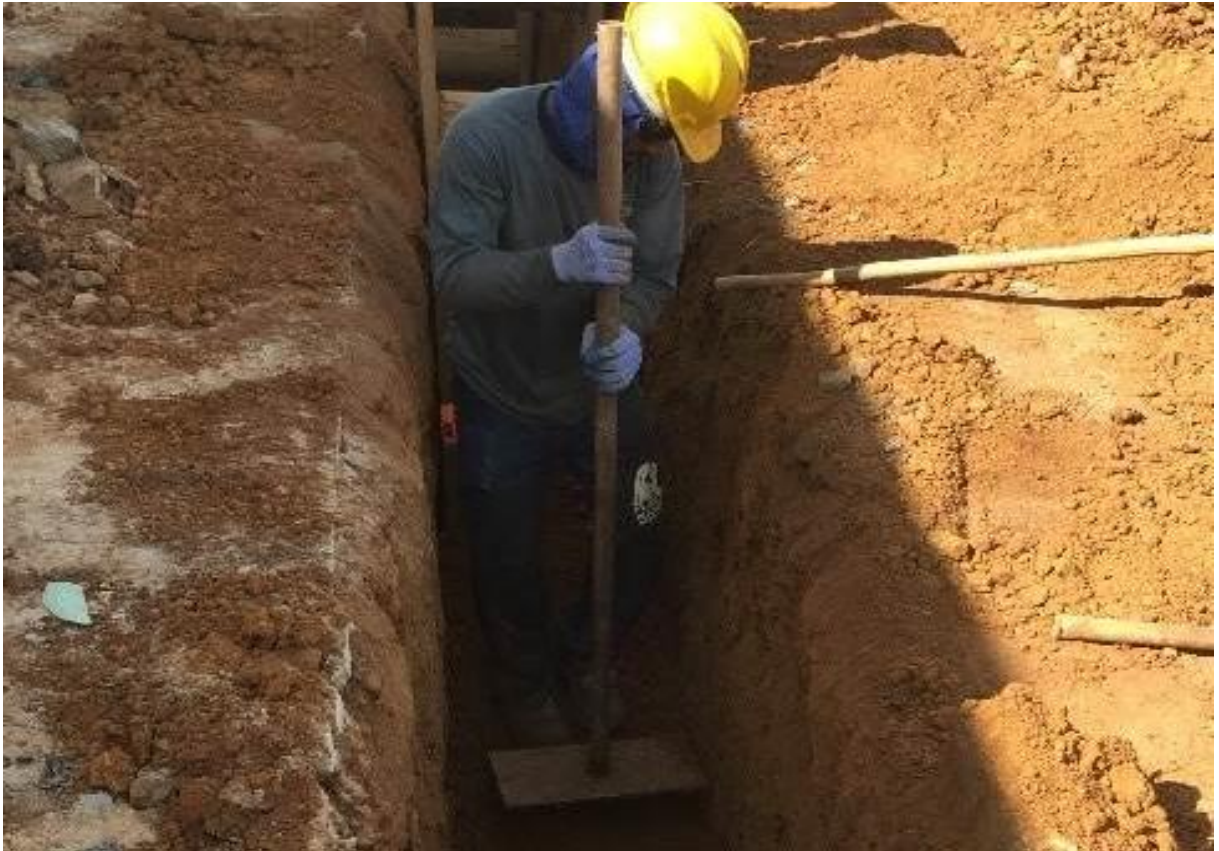
Figura 11. Reaterro do tipo apiloamento.
