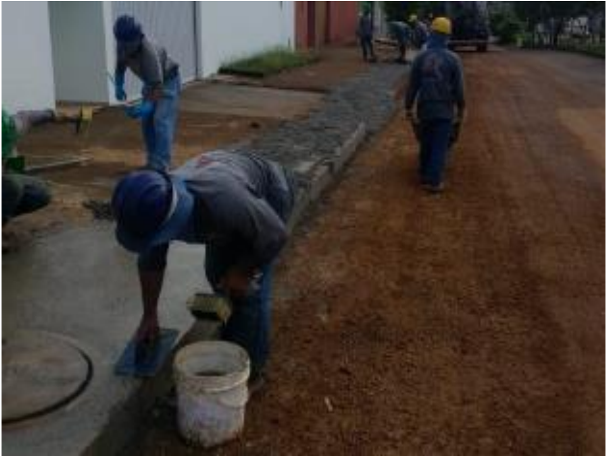
Figura 13. Reposição de calçada.
