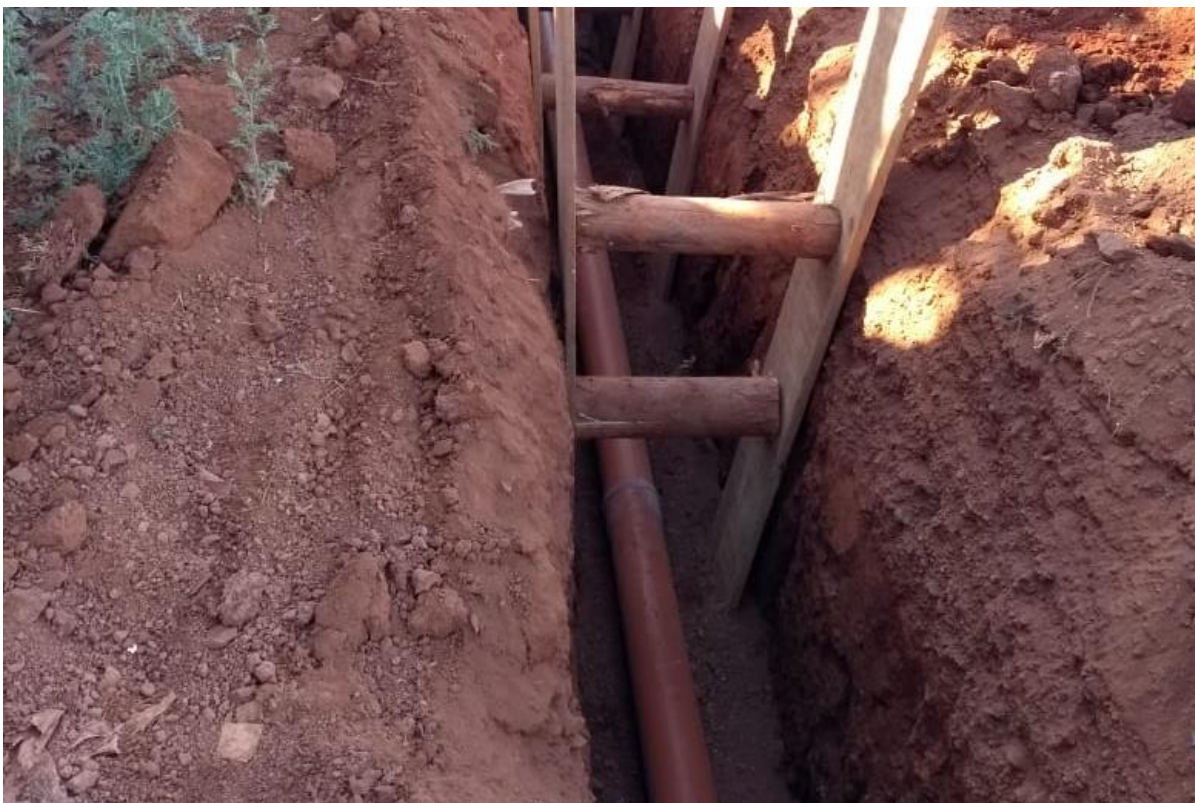
Figura 7. Montagem da rede.
