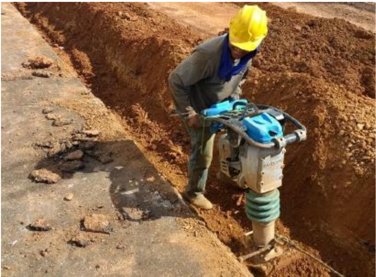
Figura 12. Reaterro compactado com sapo mecânico.
