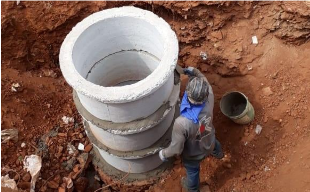
Figura 9. Execução do PV convencional de concreto.
