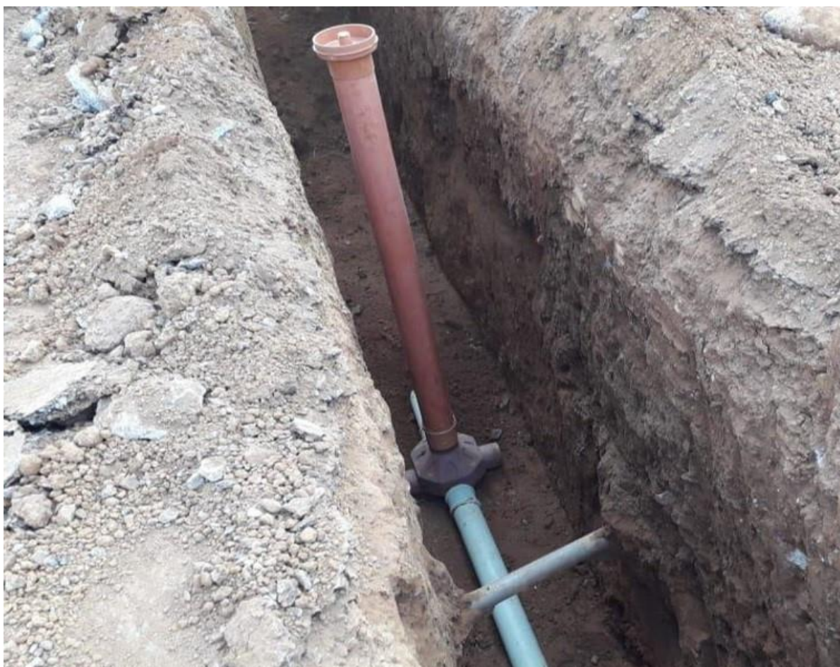
Figura 8. Execução do TIL.
