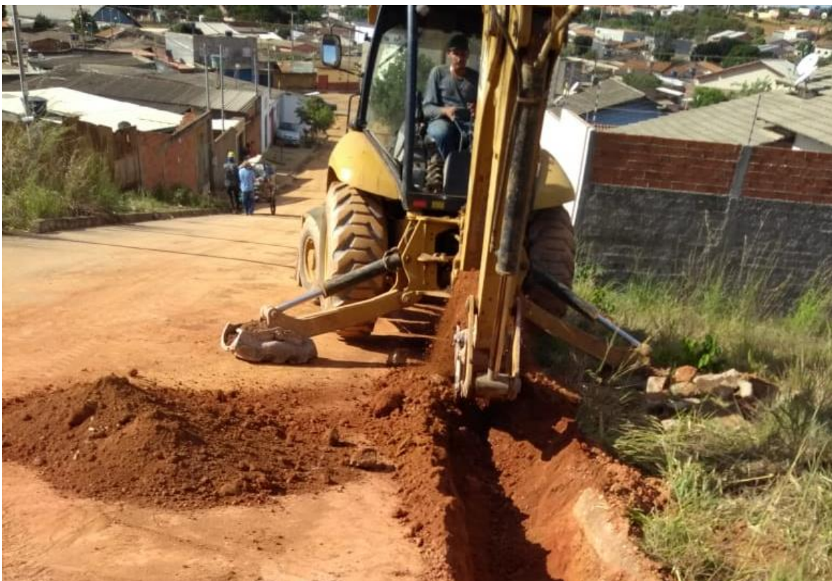
Figura 4. Serviço de escavação feita com retroescavadeira.
