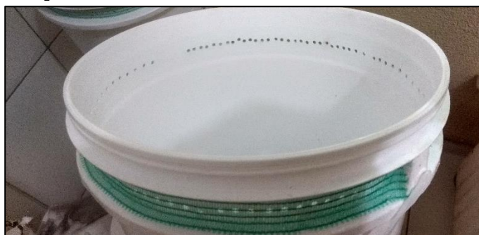
Figura 3. Furos laterais para entrada de oxigênio na composteira.
