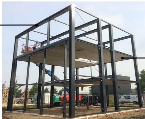
Figura 84 : Sistema estrutural metálico Fonte: Engenhariadaconstrução
