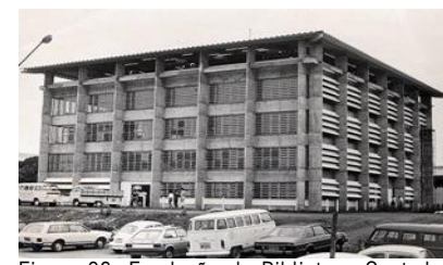
Figura 36: Fundação da Biblioteca Central em 1985. Fonte: PucGo (2020).
