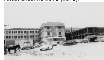
Figura 35: Fundação do HC em 1962. Fonte: Ebsearch (2016).
