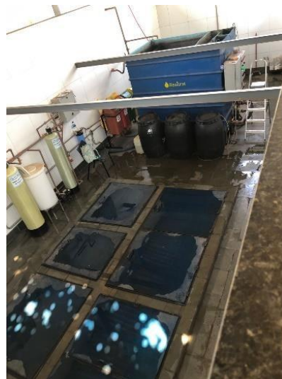
Figura 4 - Vista Aérea do Sistema de Tratamento.
