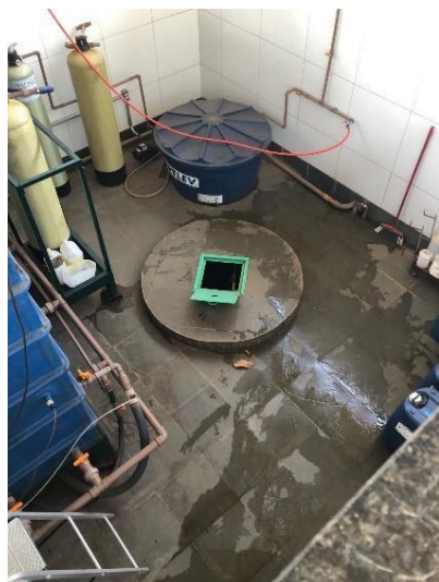
Figura 5 - Vista Aérea do Poço de Armazenamento.
