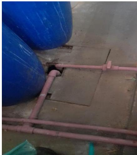
Figura 11. Imagem (P): Reservatório de descarga do lodo. (P)
