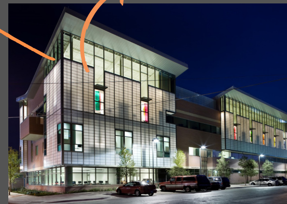
Figura 10: Fachada The Bridge Fonte: Overland Partners
