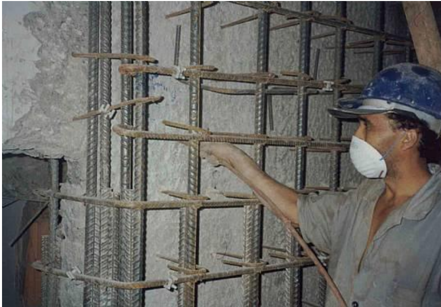
Figura 7 – Limpeza da superfície com ar comprimido Fonte: Andrade Neto (2012)
