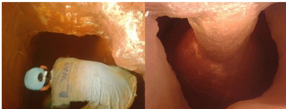
Figura 2 e 3 – Detalhe do tubulão escavado
