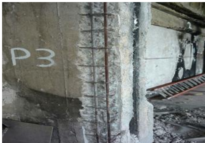
Figura 5 – Escarificação do pilar Fonte: http://www.etu.ufrj.br/files/fotos/1529505319.png
