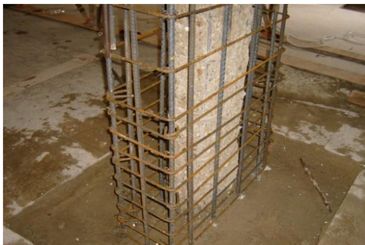
Figura 10 – Pilar pronto para concretagem
