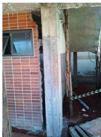
Figura 11 – Pilar “A” Reforçado na Forma Figura 12 – Pilar “B” Reforçado Concretado Fonte: Andrade Neto (2012)
