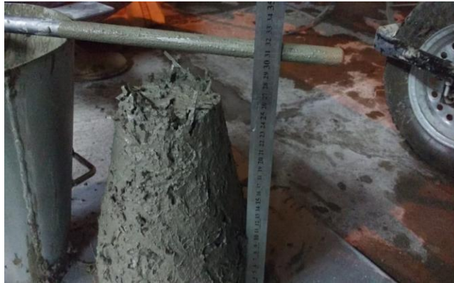
Figura 2 - Determinação do abatimento do concreto "Slump Test".
