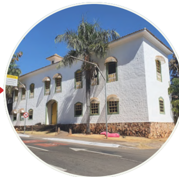
Figura 28 – Vista Instituto Fonte: Acervo do autor
