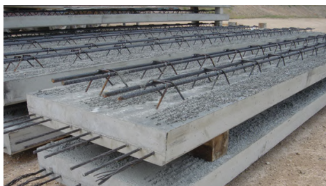
Figura 69 – Estrutura | Fonte: concreto mônico
