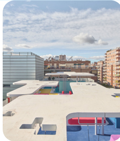
Figura 20 Cobertura do Hospital. Fonte: ArchDaily, 2021.
