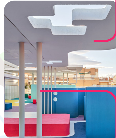
Figura 22 Cobertura do Hospital. Fonte: ArchDaily, 2021.
