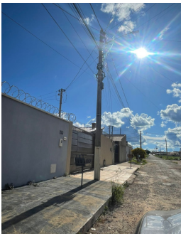
Fig. 48: Iluminação e Fonte: Autora, 2025
