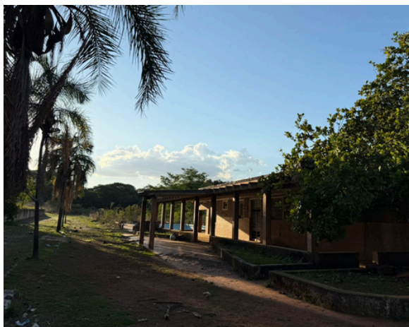
Fig.: 61: Edifício Existente | Fonte: Autora, 2025
