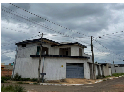
Fig. 39: Residência de 2 pavimentos Fonte: Autora, 2025
