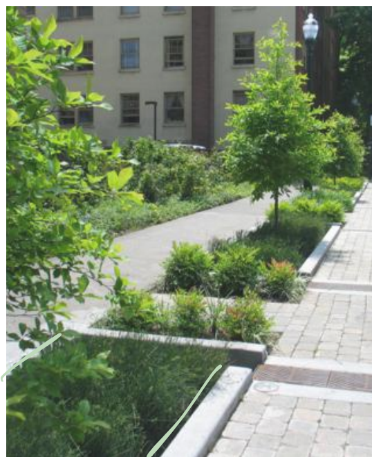
Fig. 62: Canteiros Pluviais Fonte: paisagismoemfoco.com.br
