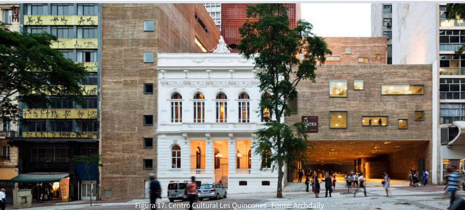
Figura 16: Centro Cultural Les Quinconces Fonte: Archdaily
