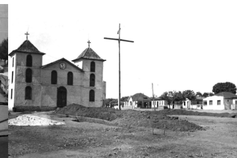
Figura 45: Foto construção da matriz de campinas Foto: Hélio de Oliveira/ internet
