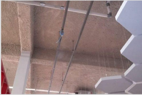
Fig. 35, Jateamento Lã de Vidro. Fonte: jatoacustica.com.br, 2025.
