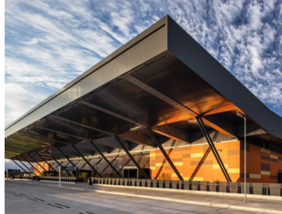
Fig 60 . Estrutura metálicas. Fonte: Archdaily, 2023.
