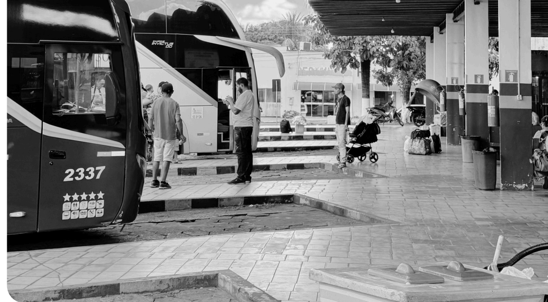
Fig 5. Rodoviária de Colinas do Tocantins-TO. Fonte: Acervo Rayka Souza, 2025
