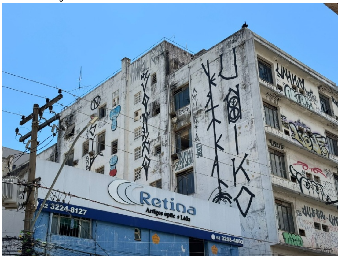
Figura 02. Imóvel com sinais de abandono no Centro de Goiânia, rua 08.
