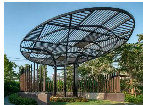
Fig.: 55: Pergolado de ferro Fonte: Google, 2026
