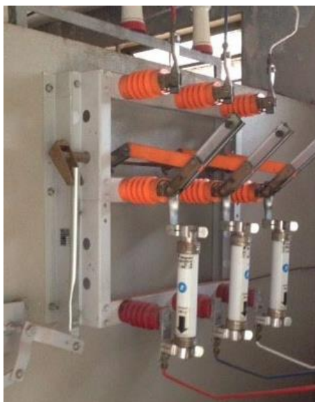
Figura 4 – Chave Seccionadora Tripolar 15KV 400A
