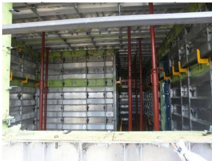
Figura 10 - Fôrmas de alumínio para execução de paredes de concreto moldadas in loco
