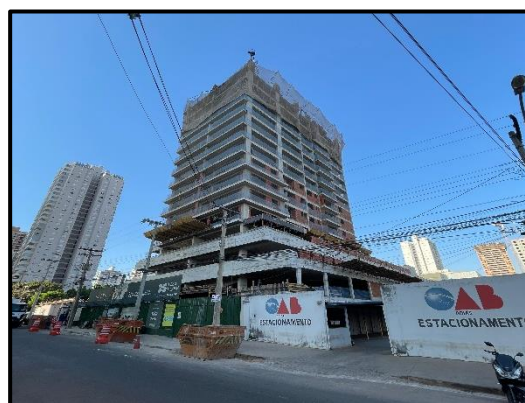
Fachada Lateral Direita
