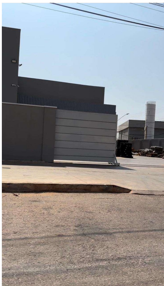
Figura 15 – Localização atual do portão na rua do trabalho
