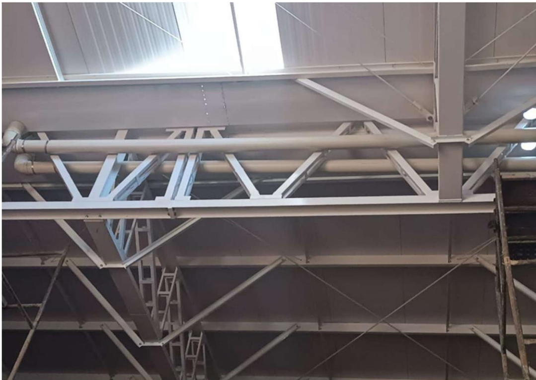
Figura 12 – Cobertura metálica finalizada
