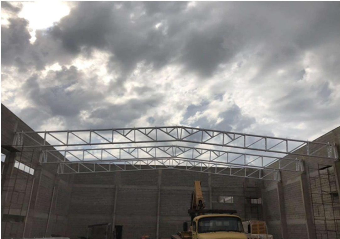
Figura 11 – Instalação das treliças de cobertura
