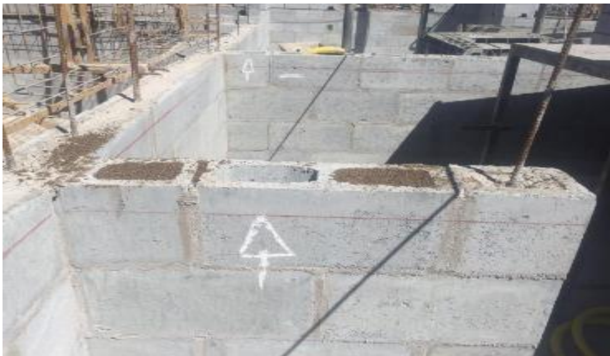
Figura 5 - Aplicação de Vermiculita
