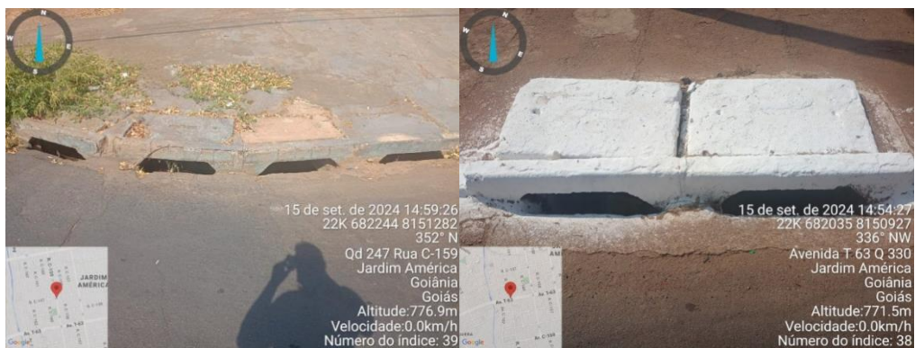
Figura 9 e Figura 10. Ponto 1 e 2 respectivamente, indicando sistema conjugado com obstrução da entrada
