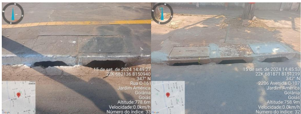
Figura 13 e Figura 14. Identificação de obstrução por resíduos, pontos 5 e 6 respectivamente
