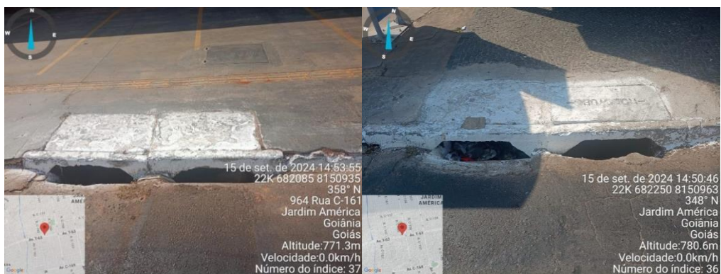
Figura 11 e Figura 12. Pontos 3 e 4 com sistemas conjugados, do tipo chapéu
