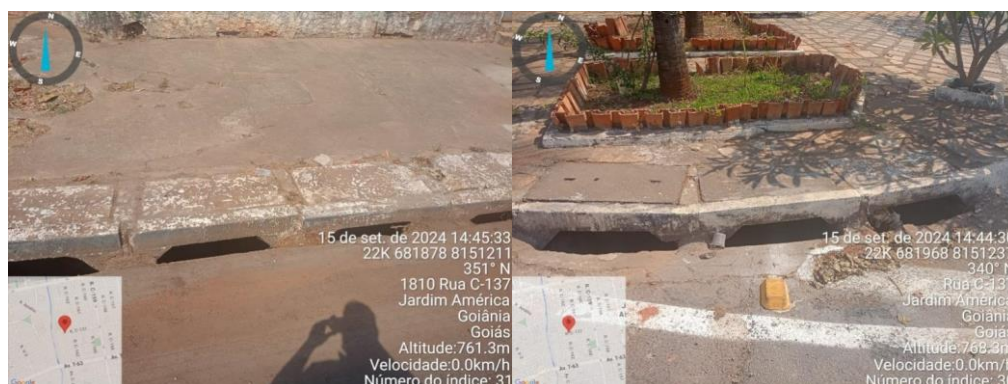
Figura 17 e Figura 18. Presença de resíduos e obstruções de entrada da água nos pontos 9 e 10
