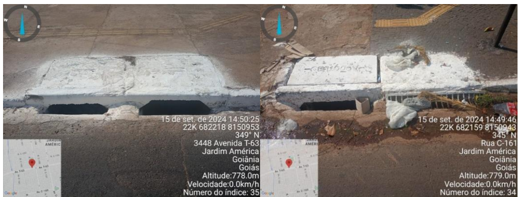
Figura 13 e Figura 14. Identificação de obstrução por resíduos, pontos 5 e 6 respectivamente
